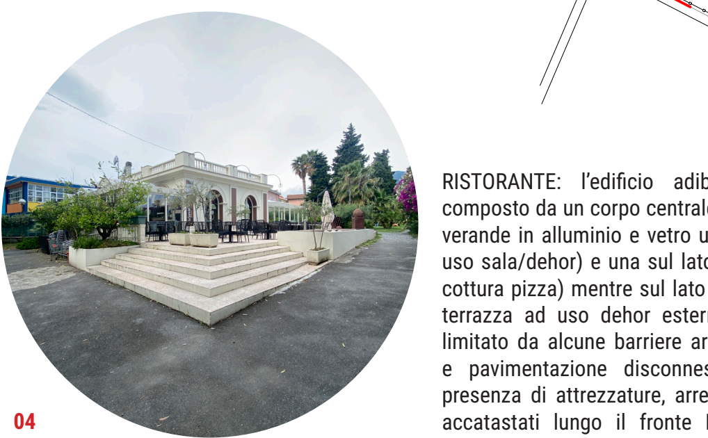
04 RISTORANTE: l'edificio adibito a ristorante è composto da un corpo centrale di fabbrica e da due verande in alluminio e vetro una sul lato Ovest (ad uso sala/dehor) e una sul lato Est (ad uso cucina/cottura pizza) mentre sul lato Nord è dotato di una terrazza ad uso dehor esterno, il cui accesso è limitato da alcune barriere architettoniche (gradini e pavimentazione disconnessa). Si segnala la presenza di attrezzature, arredi e bidoni dei rifiuti accatastati lungo il fronte Est dell'edificio (che peraltro affaccia sulle aree gioco e sulla corsia di accesso diretto al cortile interno dell'asilo Simone Stella (nella sua porzione di proprietà del Comune);
